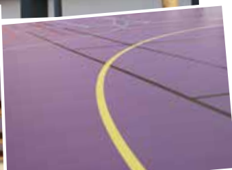
RÉFECTION DES SOLS
