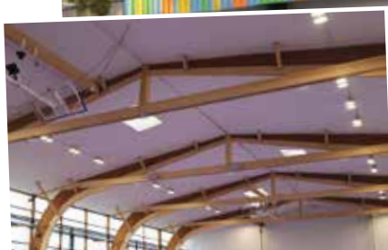
RENFORCEMENT DE LA CHARPENTE
