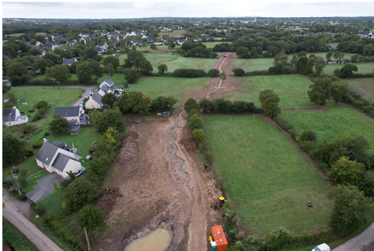
Travaux sur le ruisseau de St-André
