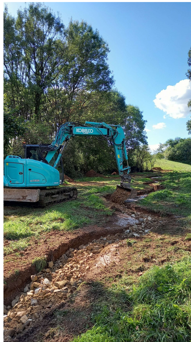
Travaux sur le ruisseau de Campbon
